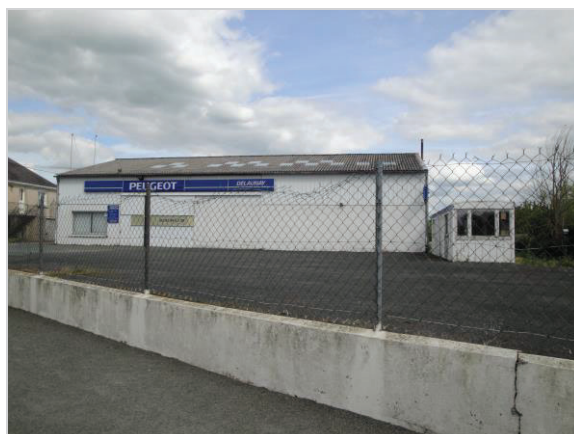
Photographie 14 : Anciens locaux du garage Peugeot Delaunay
