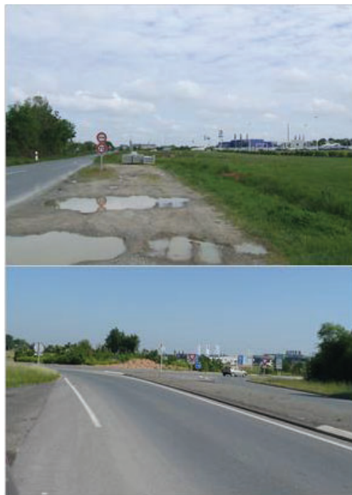
Photographie 15 : Zone de protection visuelle peu valorisante et végétation du giratoire obstruant les vues sur l'Abbaye et l'église
